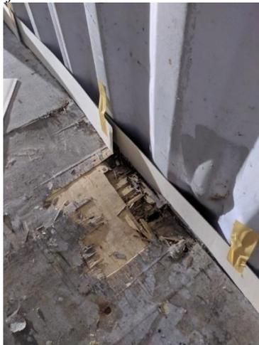
**Gambar 10.** Lantai *Container* Rusak Pada Posisi Pinggir *Container*
