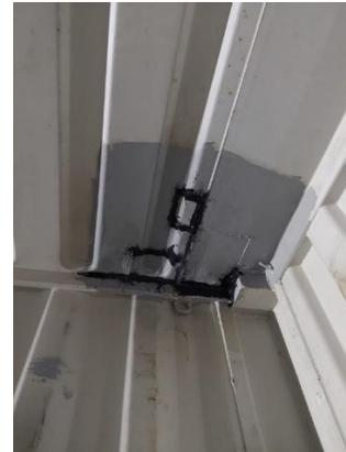
**Gambar 7.** Kondisi Atap Bocor Setelah Dilakukan Penambalan
