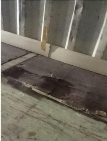
**Gambar 8.** Lantai *Container* Rusak Tepat Pada Jalur Roda *Forklift*
