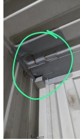
**Gambar 6.** Kondisi Atap Bocor Sebelum Dilakukan Penambalan
