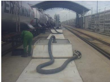
**Gambar 6 Peletakan Flexible Hose**
