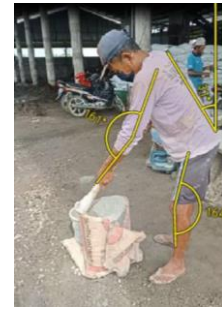
Gambar 6 Mengambil Semen ke dalam Ember
