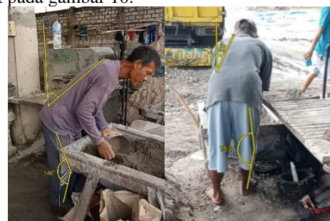
Gambar 10 Memasukkan Bahan Campuran A ke Wadah (a) Pekerja 1 (b) Pekerja 2
