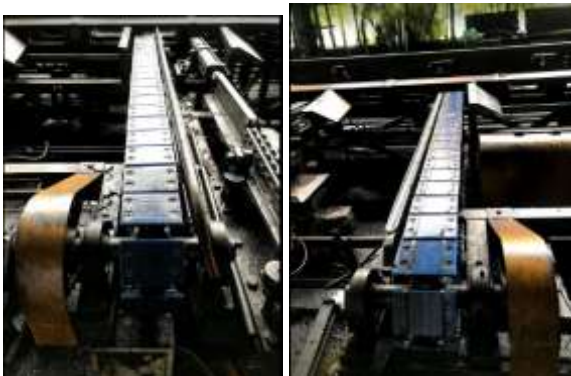
Gambar 3. Permukaan Pillar sebelum (kiri) dan sesudah (kanan) perbaikan
