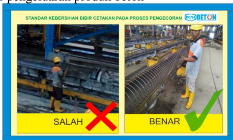
Gambar 6. Desain visual display pada pekerjaan membersihkan bibir cetakan pada proses pengecoran beton
