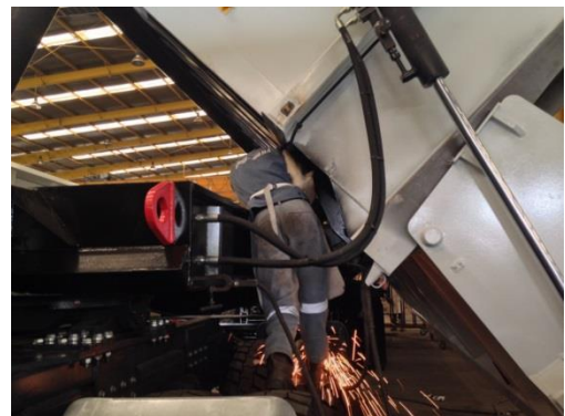
Gambar 4. Foto Postur Kerja Welder
