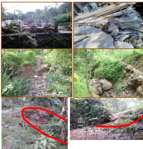
Gambar 4.2 Bidang Rekahan di sebelah selatan Dusun Gondanglegi
