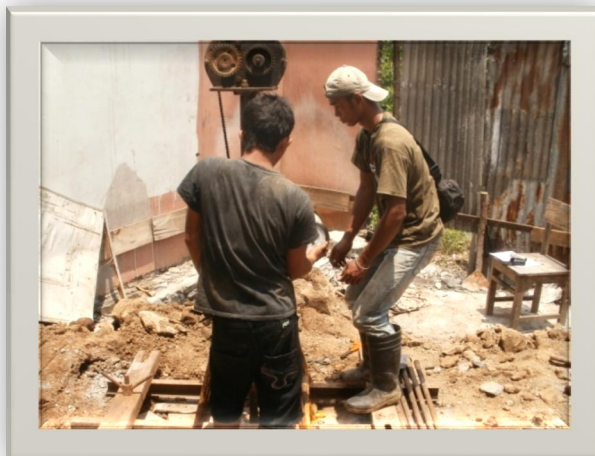
Lampiran 1. Foto Akifitas Pekerjaan Sondir Penyelidikan Tanah SMK Teuku Umar (PT. Selimut Bumi Adhi Cipta, 2012)
