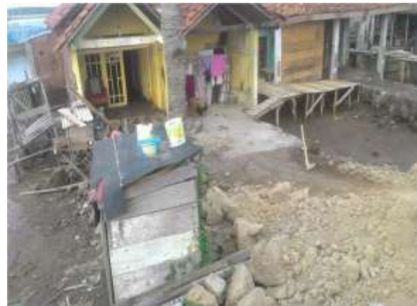
Gambar 8. Rumah Warga yang terkena dampak Penurunan Tanah
