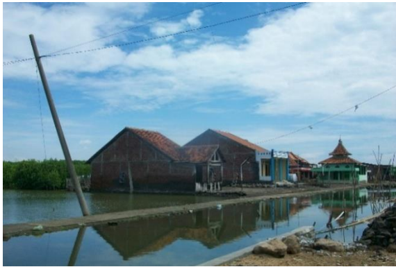
Gambar IV.9. Tiang Listrik Yang Miring Akibat Berdiri di Lokasi Rob
